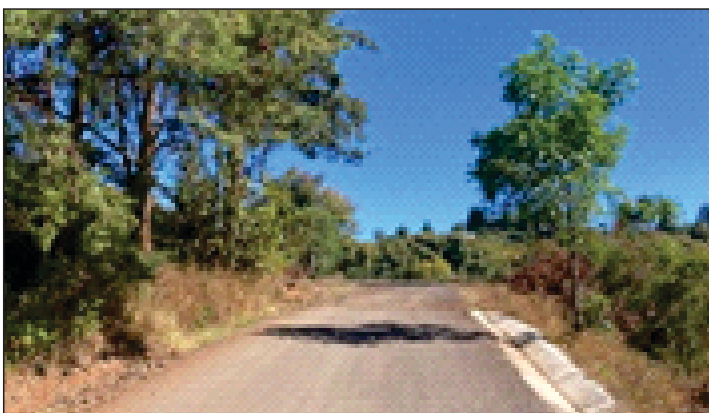
Rehabilitación de Camino en La Localidad de Buen Suceso Tramo La Sandía, Inversión: $1,881,404.45, 3,050 Beneficiarios
