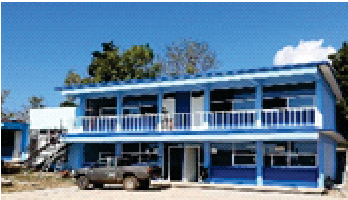
Aula en Colegio de Bachilleres Plantel Ario, 965 Estudiantes beneficiados, Inversión 100% Municipal $ 814,995.85, 128 m2 de Construcción
