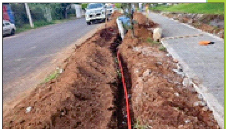
Ampliación de Alumbrado Público en la Cabecera Municipal de Ario Michoacán, Inversión: $798,741.20, 18,097 Beneficiarios
