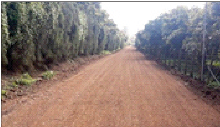
Rehabilitación de Camino en Ario Localidad de La Sandía camino de Acceso, Inversión: $798,473.70, 137 Beneficiarios
