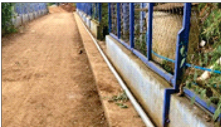
Construcción de Red o Sistema de Agua Entubada en Ario Localidad de Ario de Rosales, Colonia La Escondida Inversión: $212,945.00, 1,185 Beneficiarios
