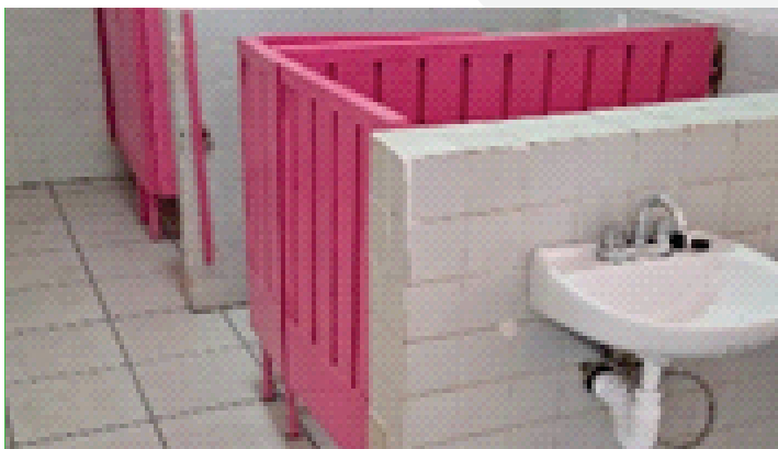
Rehabilitación de Sanitarios en el JN Enrique González Martínez de Urapa, 68 Estudiantes beneficiados, Inversión 100% Municipal $99,868.98, 24 m2
