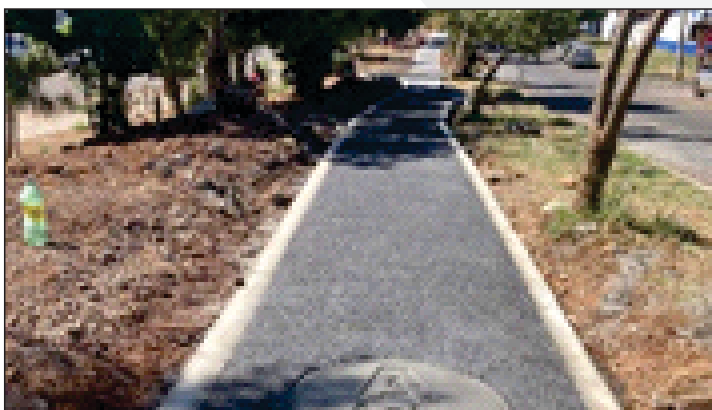
Construcción de Andador Urbano en Ario Localidad de Ario de Rosales en el Boulevard J. Mújica Inversión: $2,299,992.10, 18,097 Beneficiarios
