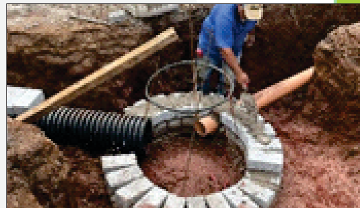
Construcción de Drenaje Sanitario en Ario Localidad de Ario de Rosales, Colonia Citlalmina Inversión: $220,583.48, 117 mts, 2,040 Beneficiarios
