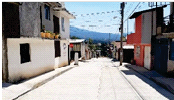
Construcción de Pavimentación en Ario Localidad de Ario de Rosales Colonia Cuauhtémoc, Calle Moctezuma Inversión: $2,311,714.32, 2,040 Beneficiarios
