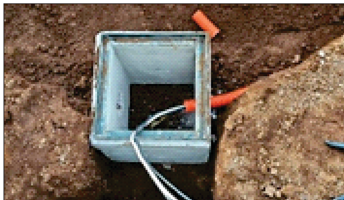
Construcción de Drenaje Sanitario en Ario Localidad de San José de Chuen Inversión: $ 119,380.98, 602 Beneficiarios
