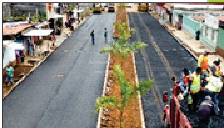
Construcción de Pavimentación en Ario Localidad de Urapa Calle Madero, Inversión: $2,175,993.79, 912 Beneficiarios
