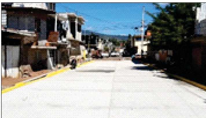
Construcción de Pavimentación en Ario Localidad de Ario de Rosales Colonia Verónica López González, Calle Ampliación Martha Reyes Inversión: $823,719.96, 2,226 Beneficiarios
