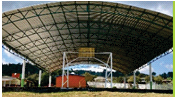
Techumbre: Telesecundaria de El Tepamal, 60 Estudiantes beneficiados, Inversión 100% Municipal $ 431,297.22, 600 m2 de Construcción
