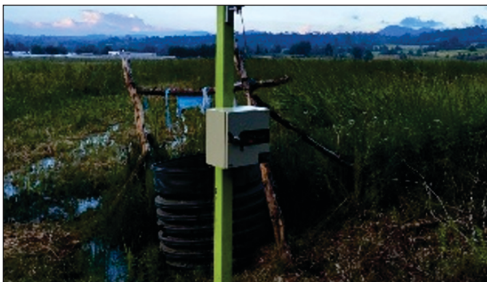
Rehabilitación del Sistema de Agua Entubada en Ario Localidad de La Finca (el Ojo de Agua) En el Manantial denominado La Finca Inversión: $602,857.97, 16,595 Beneficiarios
