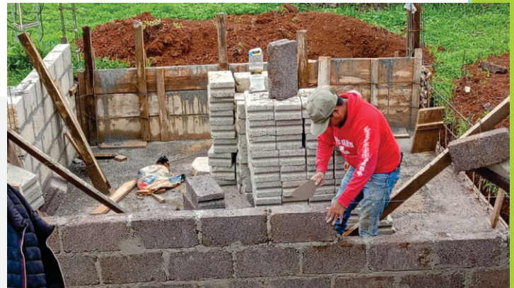
Ampliación de Centro de Salud en la Comunidad de San José de Chuen, 602 Beneficiarios, Inversión 100% Municipal, Obra en proceso
