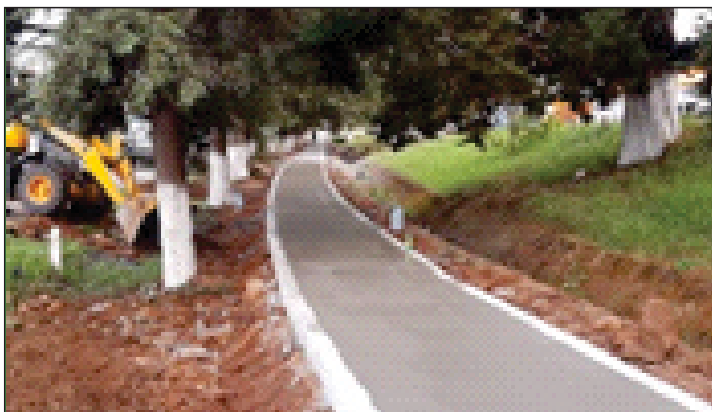
Construcción de Andador Urbano en Ario Localidad Ario de Rosales en el Boulevard Lázaro Cárdenas Inversión: $1,699,868.85, 16,595 Beneficiarios
